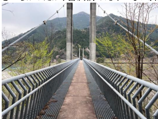
南アルプス接岨大吊り橋
