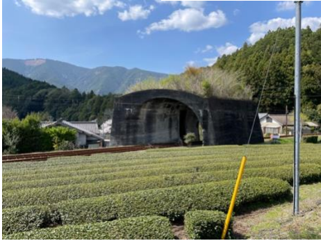
日本一短いトンネル
