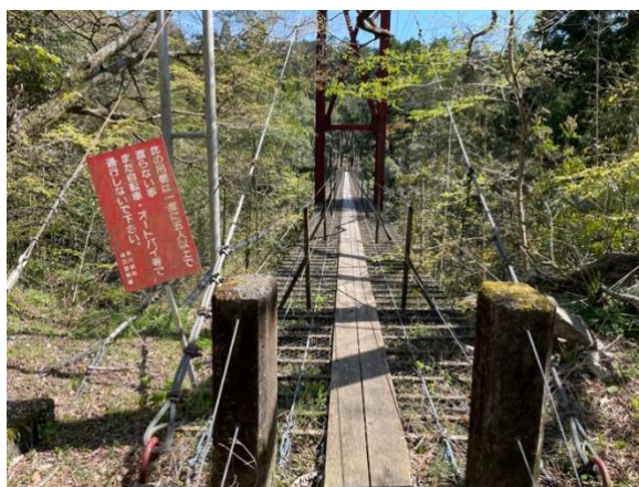
池の谷の吊り橋
