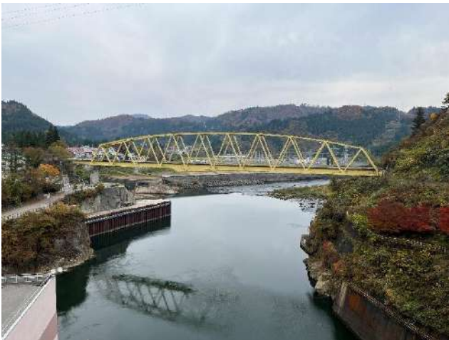
本名ダム堤体より、第六只見川橋梁
