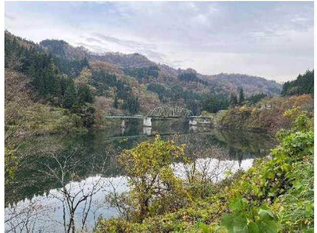
第五只見川橋梁
