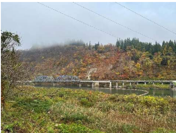
7:51 第八只見川橋梁
