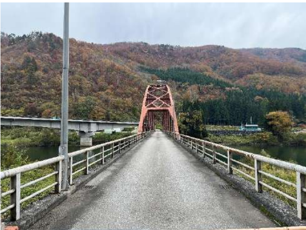
10:59 左の橋の旧橋
